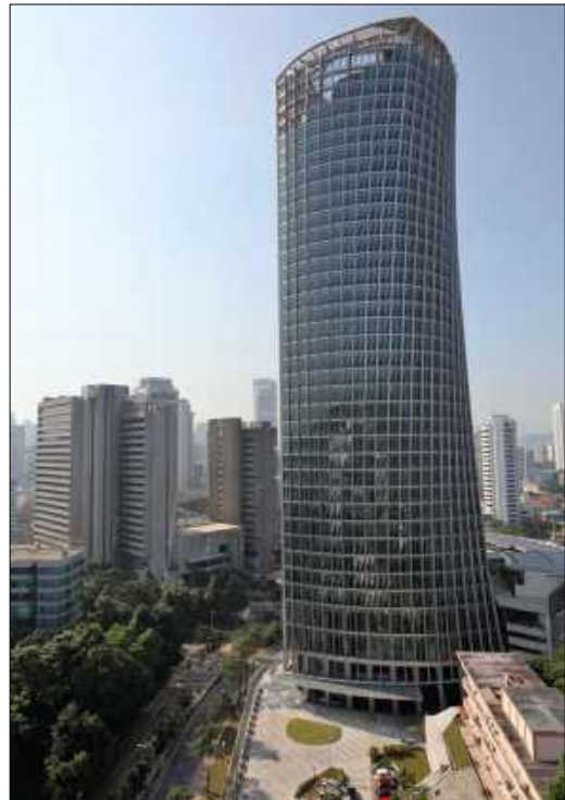
Foto 5.9: Menara Kerja Raya antara bangunan hijau di Malaysia
