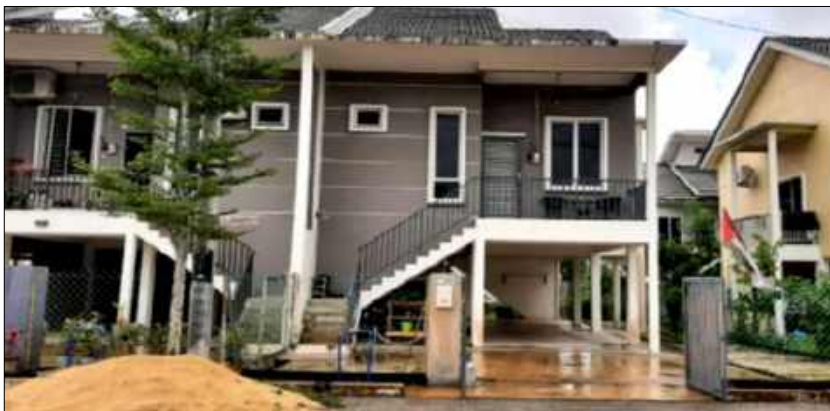
Foto 5.8: Penggunaan kaedah flood proofing bagi pembinaan rumah di Terengganu
